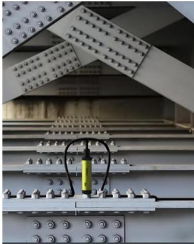
I sensori impiegati consentiranno il monitoraggio continuo da remoto abilitando un servizio digitale. Il piano di monitoraggio prevederà l'installazione di un sensore di lettura del precarico per ogni dissipatore, in numero pari quindi a 48, per l'intero edificio (16 per piano), consentendo la lettura in continuo dei valori delle forze nei bulloni per tutta la vita della struttura. L'architettura di SHM prevederà l'impiego di un gateway con le seguenti caratteristiche:
